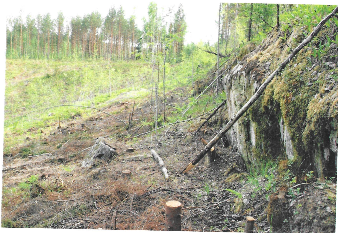
Kuva2. Kuva on otettu toimenpidealueen pohjoisreunalta jyrkänteen alta kohti etelää. Taustalla näkyvä männikkö rajaa kaivettavaa maa-alueetta.
